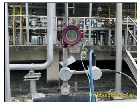
ภาพที่ 2.2-5 Gas Detector จุดที่ปฏิบัติงาน
